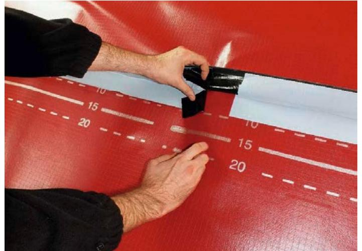
Beim Erstellen eines wasserdichten Unterdaches, wie es größtenteils bei Gauben vorkommt, sind gesonderte Maßnahmen am Steildach zu ergreifen. Koramic bietet Ihnen auch hierfür die ideale Lösung. Die Koramic Unterdeckbahn Premium Q besteht aus einem verschweißbarem Material und lässt sich mit dem Koramic Quellschweißmittel, einem handelsüblichen Heißluftgerät oder einem Schweißroboter verschweißen.
