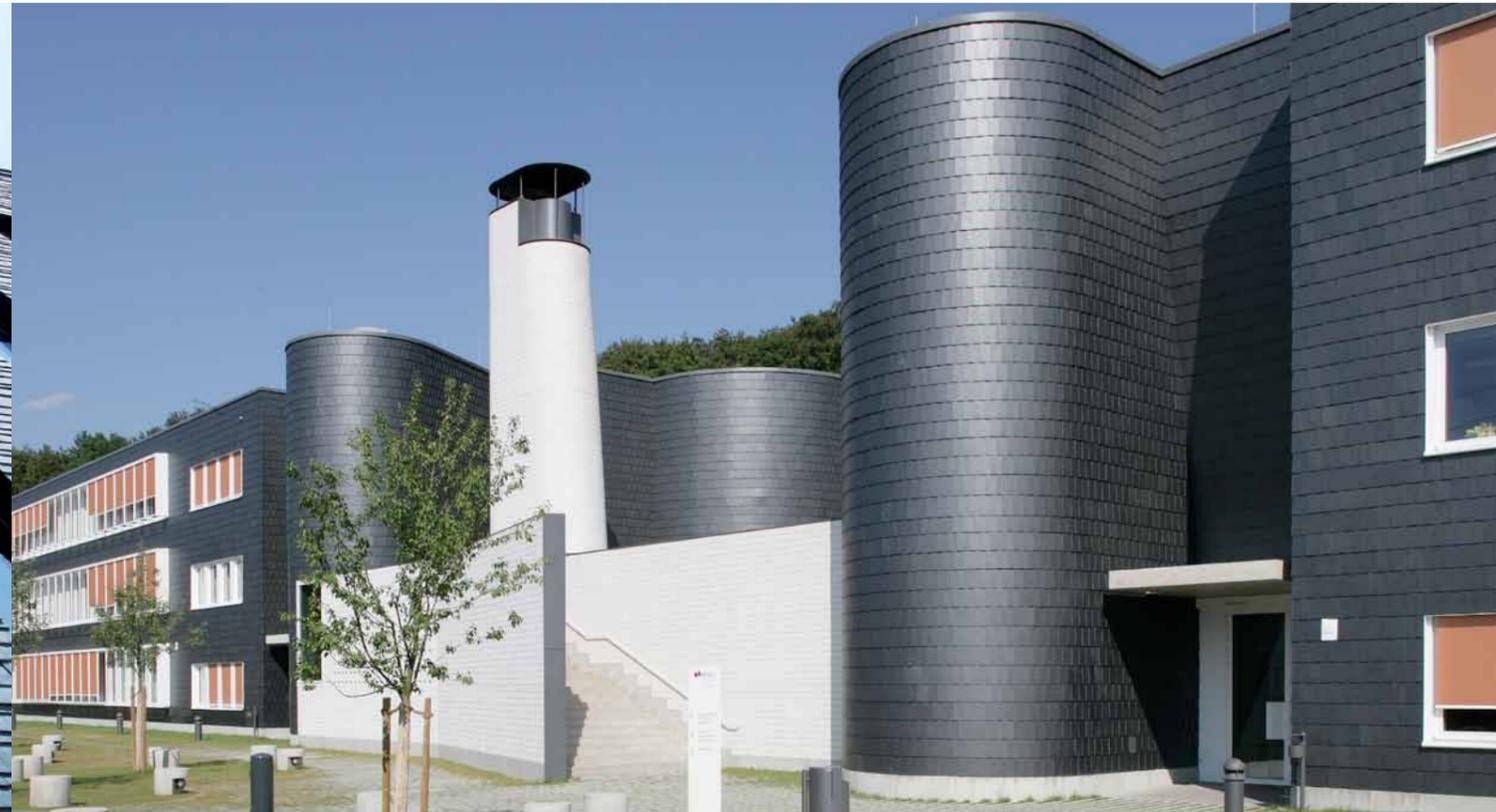
Die Waagerechte Deckung zählt durch die unkomplizierte Verlegetechnik und die hohe Materialausnutzung zu den besonders günstigen Schieferdeckarten und ist deshalb beliebt bei privaten Bauherren wie auch bei Planern großer Bauobjekte.
