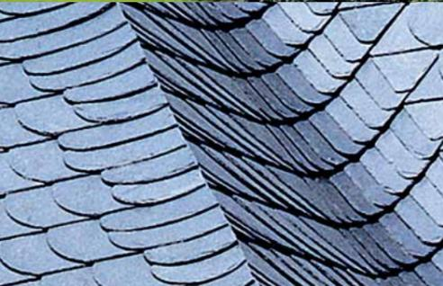
Die Form der Decksteine der Schuppen-Deckung gleicht der Gestaltung der Decksteine für die Altdeutsche Deckung, allerdings verwendet die Schuppen-Deckung gleichförmige, vorgefertigte Schablonensteine.
