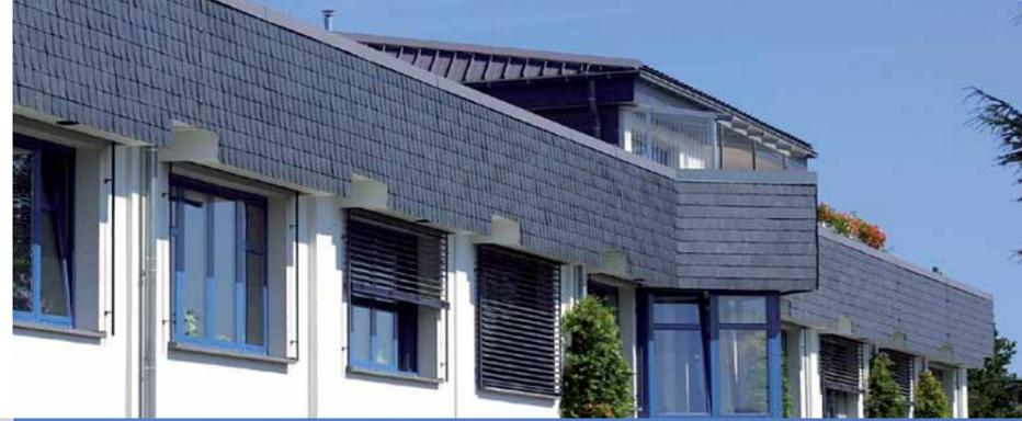
Der breite Attika-Vorbau wurde hier im Kontrast zur weißen Fassade mit dunklem Schiefer abgesetzt. Modern, spannend und außerdem langfristig werterhaltend.
