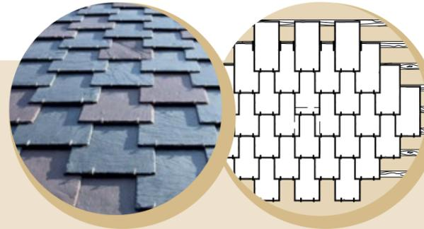
Die Gezogene Deckung ist mit fast jedem üblichen Rechteckformat ausführbar und kann verschnittminimierend an die Gebäudegeometrie angepasst werden.
