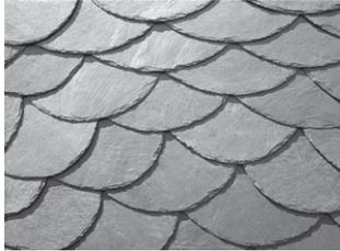
Angeliefert werden rohe, gespaltene Steine unterschiedlicher Form und Spaltdicke (Moselschiefer® Extra). Diese werden vom Dachdecker an der Baustelle bzw. auf dem Dach passend behauen und eingedeckt.
