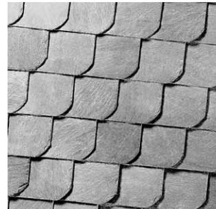
Weiterhin ist durch den gerade verlaufenden Rücken eine – gegenüber der Bogenschnitt-Schablone – größere Seitenüberdeckung im Bereich des unteren Brustloches gegeben. Dies erhöht die Regensicherheit.
