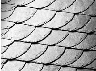
Das Hauptmerkmal der Altdeutschen Deckung ist die Verwendung von frei Hand zugerichteten Decksteinen mit deutlich unterschiedlichen Höhen und Breiten in einer Fläche. Die Altdeutschen Deckungen sind als geschlossene Deckungen auszuführen.
