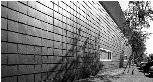
Neue Formate halten verstärkt Einzug in die moderne Fassadenarchitektur und bieten durch fortschrittliche Schneide- und Befestigungstechnik individuelle Designmöglichkeiten. Im Gegensatz zu herkömmlichen Schieferdeckarten ist bei der Symmetrischen Deckung keine Höhen- und Seitenüberdeckung der Schiefersteine erforderlich.
