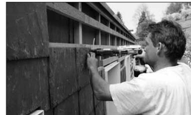
An der Wand sind Metallunterkonstruktionen (Aluminium) möglich. Für diese Befestigungstechnik eignen sich besonders die Rechteck-Deckungen.
