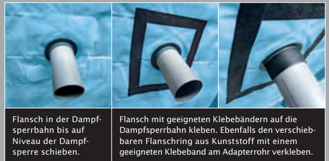
Flansch in der Dampfsperribahn bis auf Niveau der Dampfsperre schieben.
