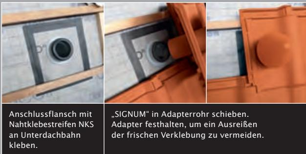
Anschlussflansch mit Nahtklebestreifen NKS an Unterdachbahn kleben.
