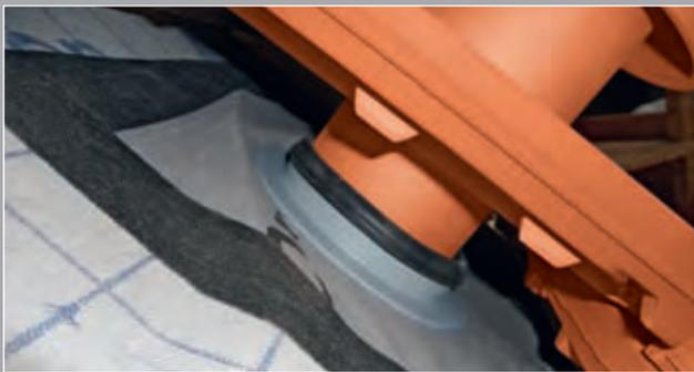
Somit ist ein fachgerechter, sicherer und schneller Anschluss des Dunstrohres an das Unterdach gewährleistet.
