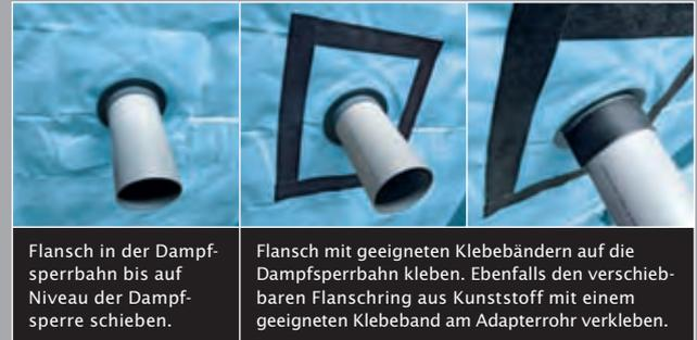
Flansch in der Dampfsperrbahn bis auf Niveau der Dampfsperre schieben.
