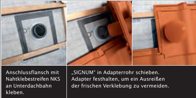
Anschlussflansch mit Nahtklebestreifen NKS an Unterdachbahn kleben.
