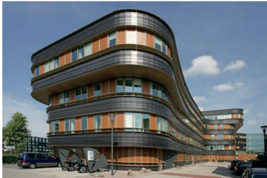
**Bild links und rechts oben:** Eine linienhafte, waagrecht gebänderte Argeton-Fassade und große auskragende Rundungen prägen das sanierte Bauwerk.
