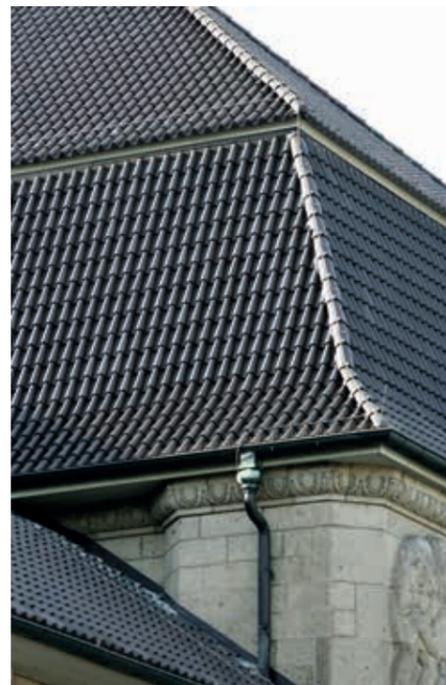
Teile des im Krieg beschädigten Daches waren bereits zu einem früheren Zeitpunkt mit einer sogenannten einteiligen kombinierten Mönch-Nonnen-Deckung gedeckt worden. Diese Deckart ist mörtelfrei und hat sich in der Denkmalpflege allgemein als Ersatzdeckung für die aufwendige, wartungsintensive und dadurch teure vermörtelte Mönch-Nonnen-Deckung durchgesetzt. Sie wurde auch hier mit ihrer Geometrie und ihrem Erscheinungsbild von der Denkmalpflege als adäquate Lösung akzeptiert.
