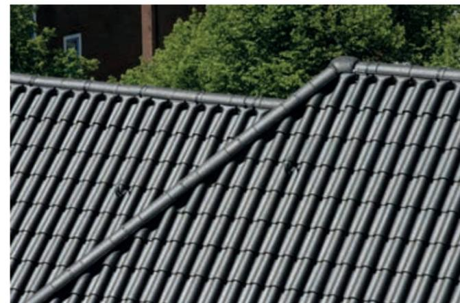
**Bild unten:** Starke Schatten, edle Farben und vollkeramische Details (First, Walmkappe, Firstanschlussziegel): mörtelfreie Mönch-Nonnen-Deckung von Wienerberger.
