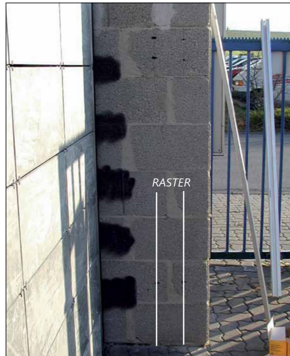
Raster: 310 mm bei Fugenbreite 10 mm.
