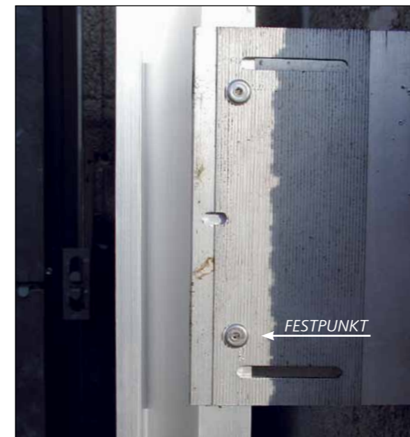
Bohrdurchmesser 5,2 mm
